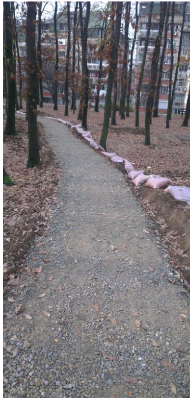
Радови на изградњи трим стазе у Миљаковачкој шуми (јесен 2014. године)
